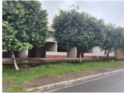
LOCALES OBRA NEGRA
