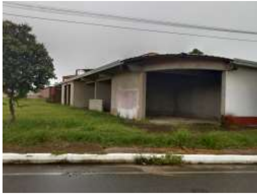
LOCALES OBRA NEGRA
